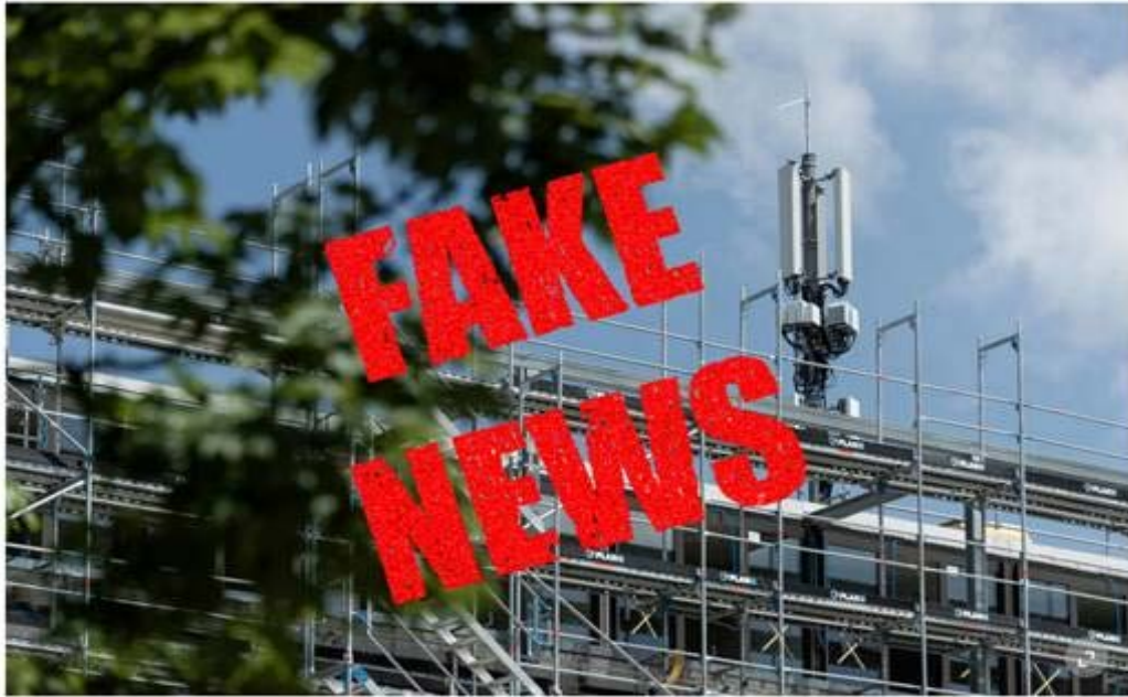
Je moderner die Anlagen sind, desto weniger strahlen sie. Eine 5G-Antenne in Langenthal. Foto: Nicola Whigg
