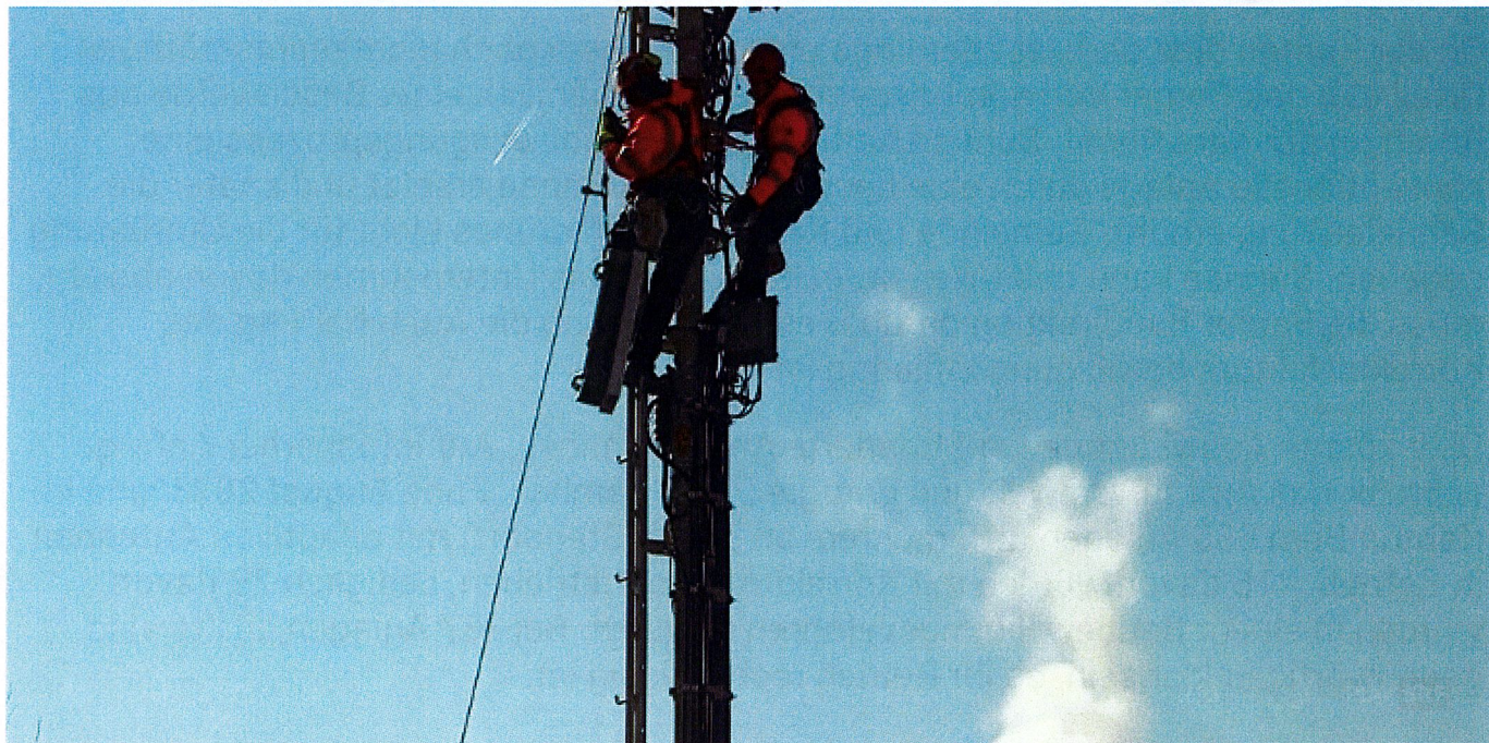
Zwei Arbeiter an einer Mobilfunkantenne. © SRF Tagesschau
